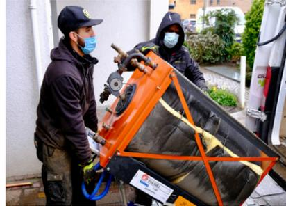
■ Mit Hilfe der EXPRESSO Sackkarren befördern die Schrottbienen bis zu 250 kg schwere Heizkessel ans Tageslicht. Zurrgurte sichern dabei die Last auf der Karre.
